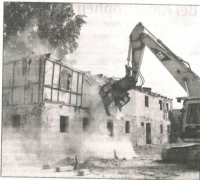
Auf dem Gelände des Pflegehofes in Wartha reißt die Entsorgungsgesellschaft Guttau mbH jetzt das alte Haupthaus des Vierseithofes ab.
